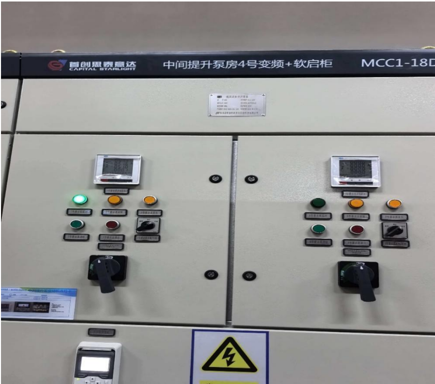
提升泵变频器+软启动照片
